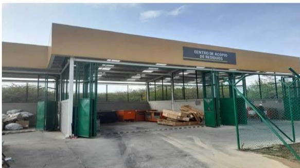
Fotografía No. 3 - Centro de Acopio para almacenamiento temporal de los RESPEL: señalizada, cercada, techada, Áreas separadas para residuos incompatibles, Buena ventilación, Pisos impermeables y resistentes estructuralmente, Cuenta con rejillas para recolección de líquidos.
